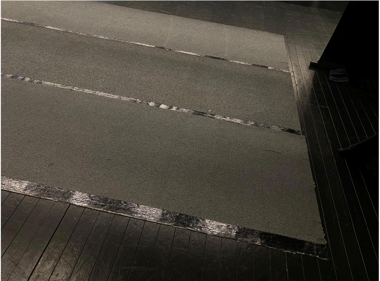
Suelo parte delantera (tela asfáltica)
